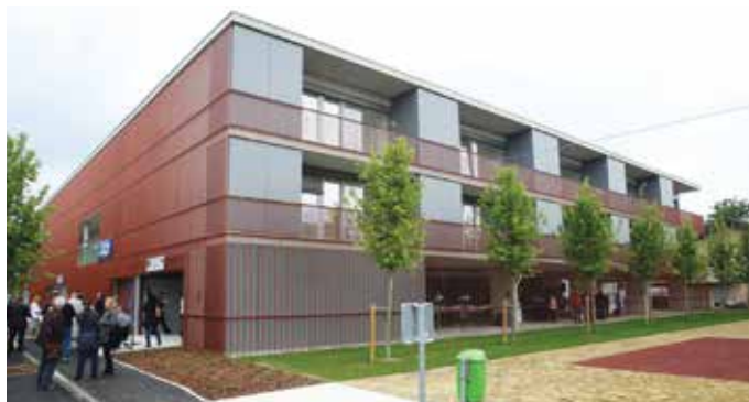
Soseska Dolgi most je sestavljena iz treh dvoetažnih stavb, v katerih je 30 dvo- in trosobnih neprofitnih stanovanj, tri pa so prilagojena gibalno oviranim osebam.
