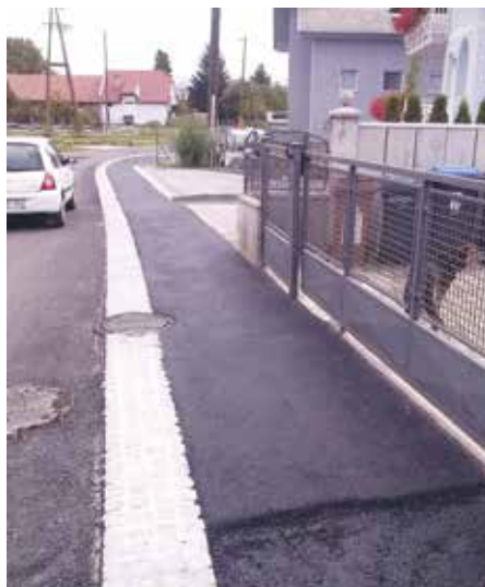
V Slapah se bodo od leta 2014 lahko pohvalili z novim plinovodom, elektrokabelsko kanalizacijo, obnovljenim vodovodom, zgrajeno fekalno in meteorno kanalizacijo, javno razsvetljavo in prenovljenim cestiščem.
