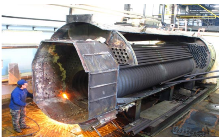
Demontaža starega parnega kotla
