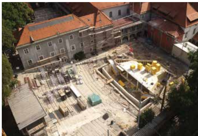
Fotografija med obnovo je narejena z dronom Energetike Ljubljana
